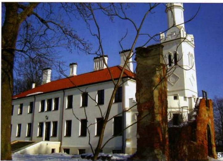
5. Zachodnia (ogrodowa) elewacja pałacu
