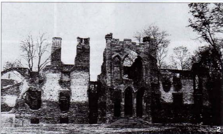
1.2. Pałac w Chrcynnie – zdjęcie wykonane w 1942 r. przez niemieckiego oficera (1) i ruiny pałacu, stan w latach sześćdziesiątych XX w. (2)
